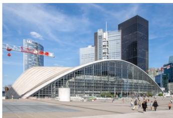
CNIT (construction 1956-58, Paris). Le bâtiment est ainsi constitué d'une voûte autoportante en béton armé de 22 500 m<sup>2</sup> pour seulement 6 cm d'épaisseur et 218 mètres de portée constituant un record du monde / illustration A. Weidmann, Wikipedia.
